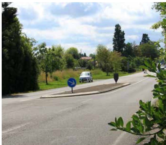
Devant être entrepris avant juin 2019, le prolongement de la piste piétonne et cyclable jusqu'aux Allées du Canal le long de la RD 813 avait été évalué à 800 000 euros.
